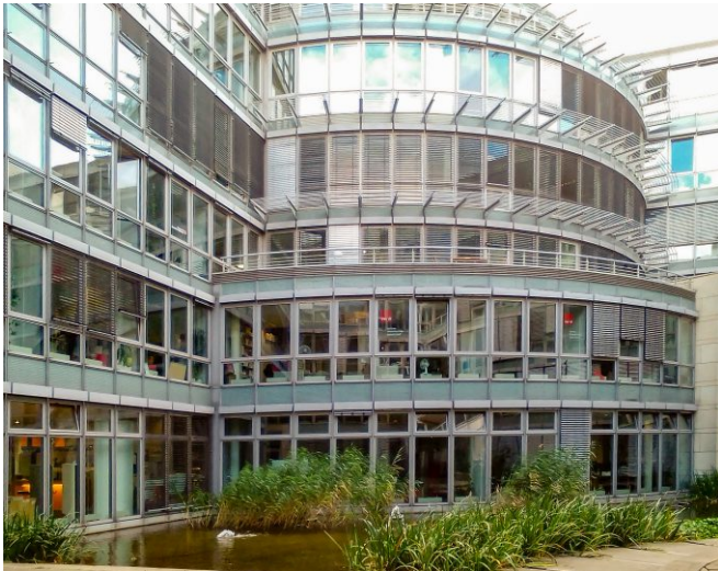
Bürogebäude Beringstraße in Dresden – Durch den angelegten Teich werden viele Vögel angezogen und kollidieren mit dem Glas
